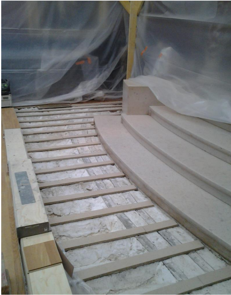
Les lambourdes du parquet de la Galerie de peinture
