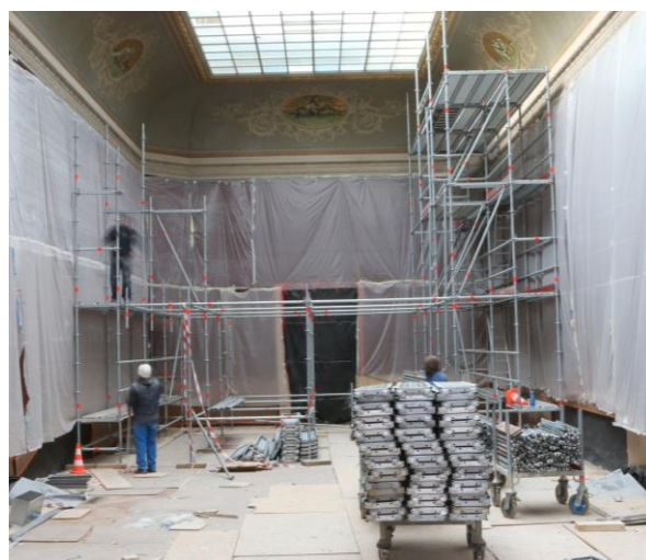
La Galerie de Peinture en travaux
